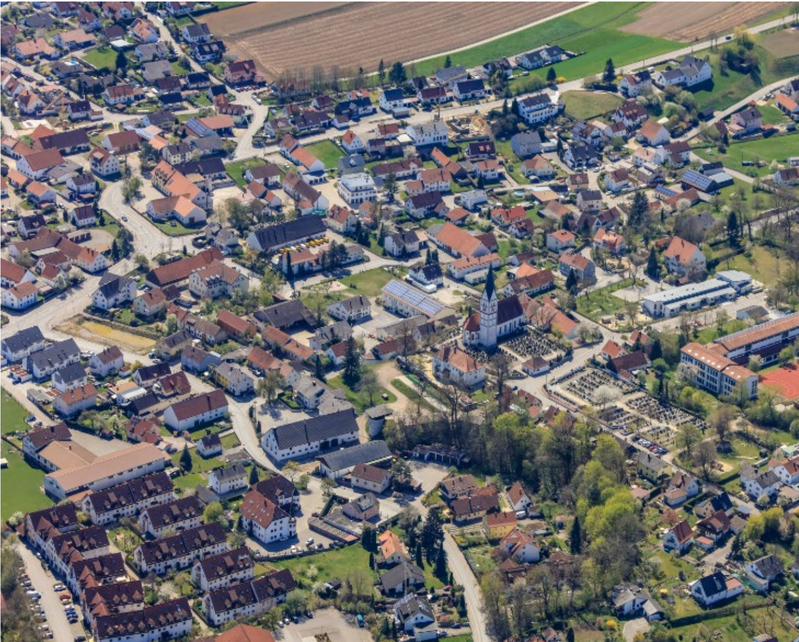
Vorbereitende Untersuchungen Das Planungsgebiet von Nordosten
